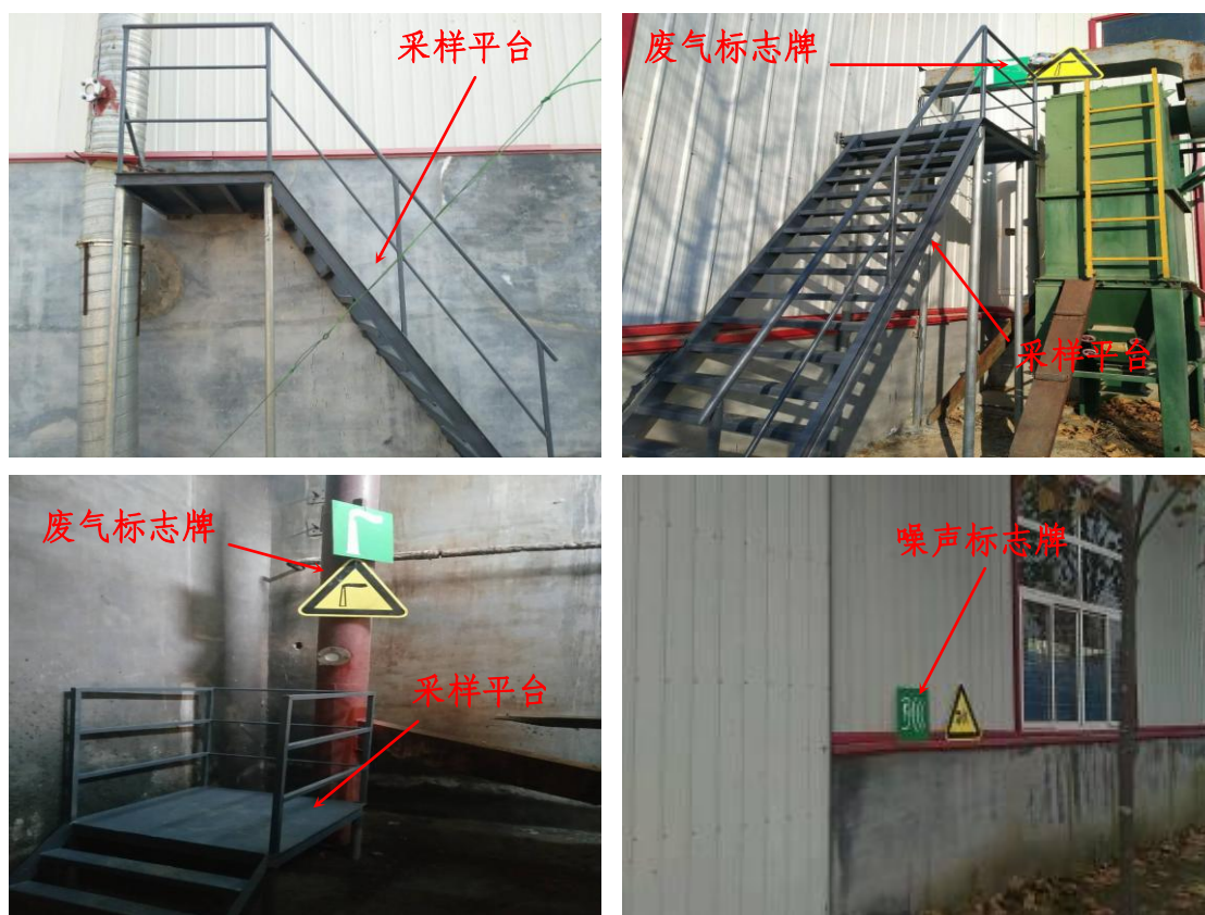
图 4-6 排污口规范化现场落实情况
