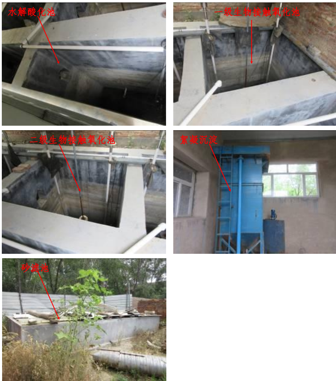
图 4-1 废水治理措施现场落实情况
